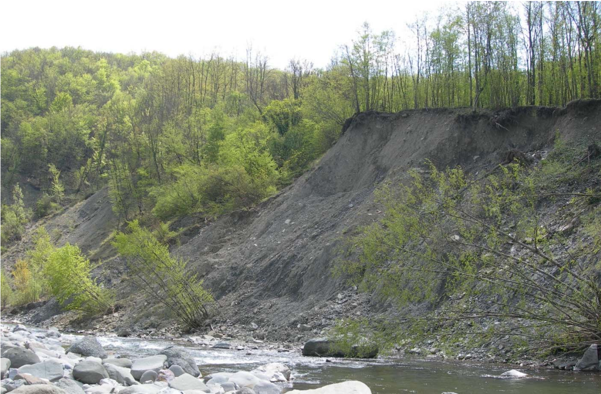
Fig. 10- Il torrente Enza scalza il piede della frana di quota 636m mettendo a nudo il deposito che nella parte basale ha uno spessore di qualche decina di metri.
